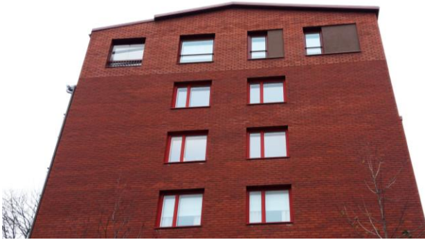
Kuva 58: Esimerkki kerrostalon yhden kerroksen laajuisesta korotuksesta (Helsinki, Kulosaari).
