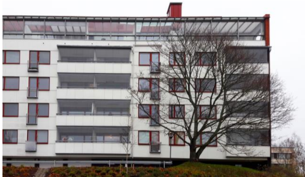
Kuva 59: Esimerkki kerrostalon yhden kerroksen laajuisesta korotuksesta (Helsinki, Kulosaari).
