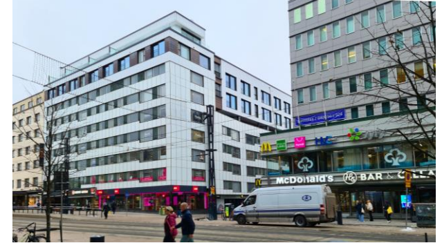
Kuva 62: Esimerkki kerrostalon kahden kerroksen laajuisesta korotuksesta (Tampere, Kyttälä).
